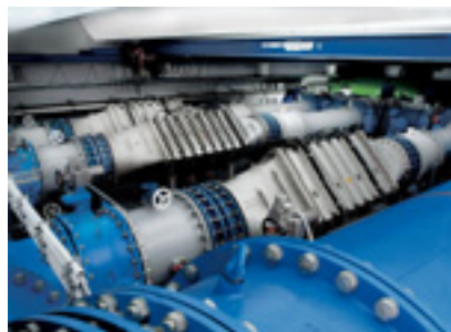
Abb. 2 UV-Anlagen mit modularem Aufbau für große Wasserversorger (> 1000 m 3 /h pro Einheit)
